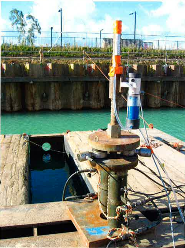
4, 5 | Beproeven ankerpalen in een natte bouwkuip (foto's: RWS Bouwdienst)
