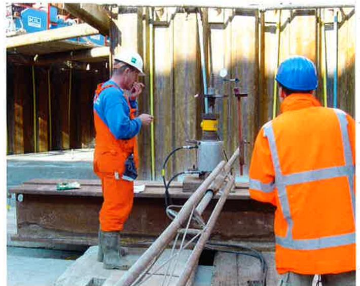
3 | Beproeven ankerpalen in droge bouwkuip (foto: Volker Staal en Funderingen)
